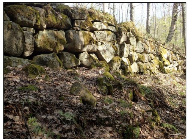
Eteläpuoleista kiveystä. Pohjoiseen. Kylmämuuratun osan alla (oikeassa kuvassa etualalla) ns. heittokivistä koostuva kylmämuuratun osan perusta. Koilliseen.
